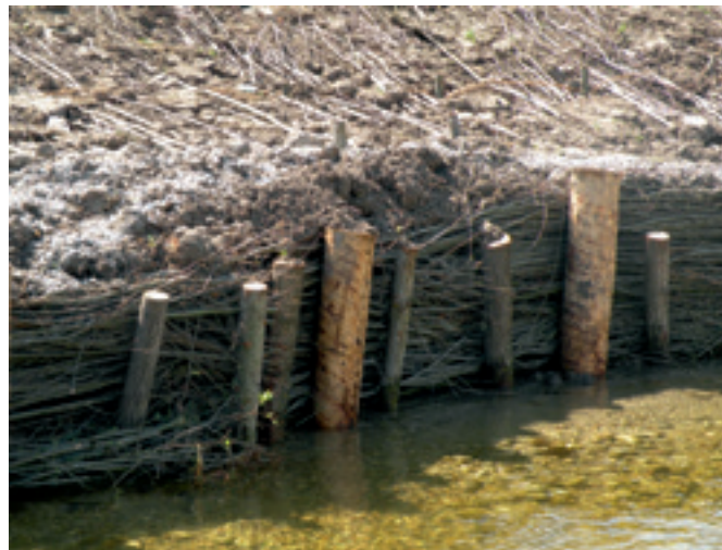
Mit Faschinen wird ein Erosionsschutz am Böschungsfuß erreicht.
