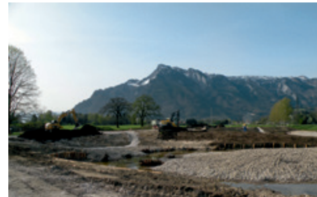
Krainerwände wurden eingebaut, um das Ufer zu sichern.
