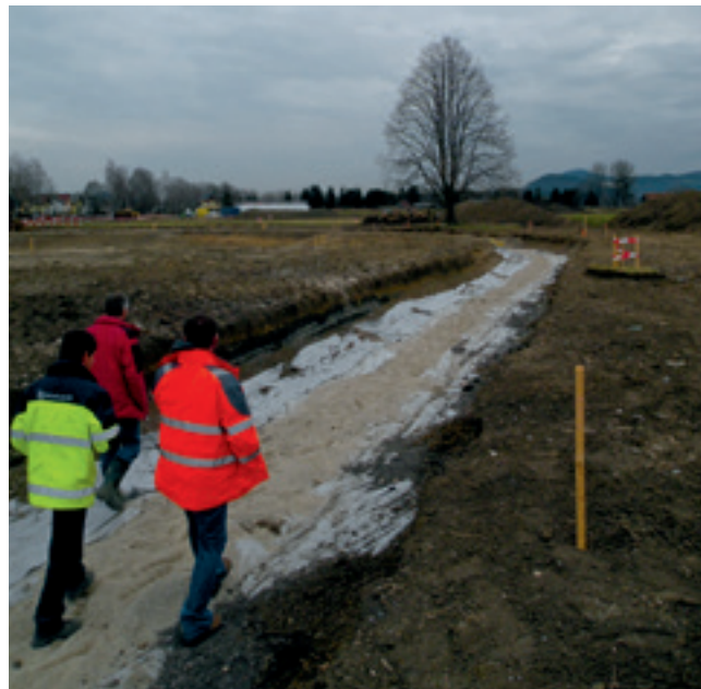
Wöchentlich fand eine Baubesprechung mit anschließender Begehung der Baustelle statt.
