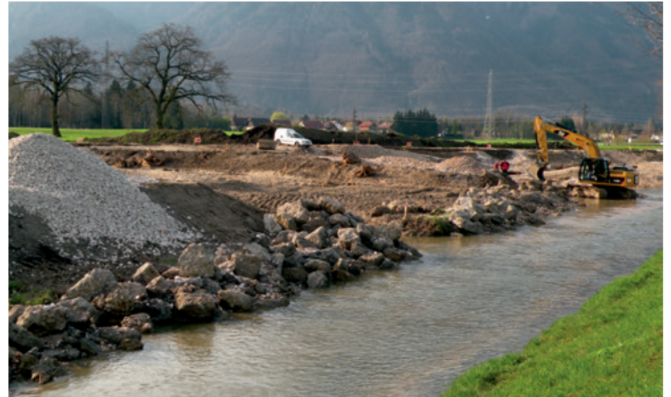
Mit großen Steinblöcken wurden Bereiche gesichert, die der Strömung besonders ausgesetzt sind.
