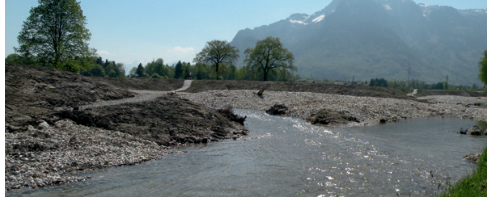
Die Glan wurde aufgeweitet und in zwei große Mäander gelenkt.
