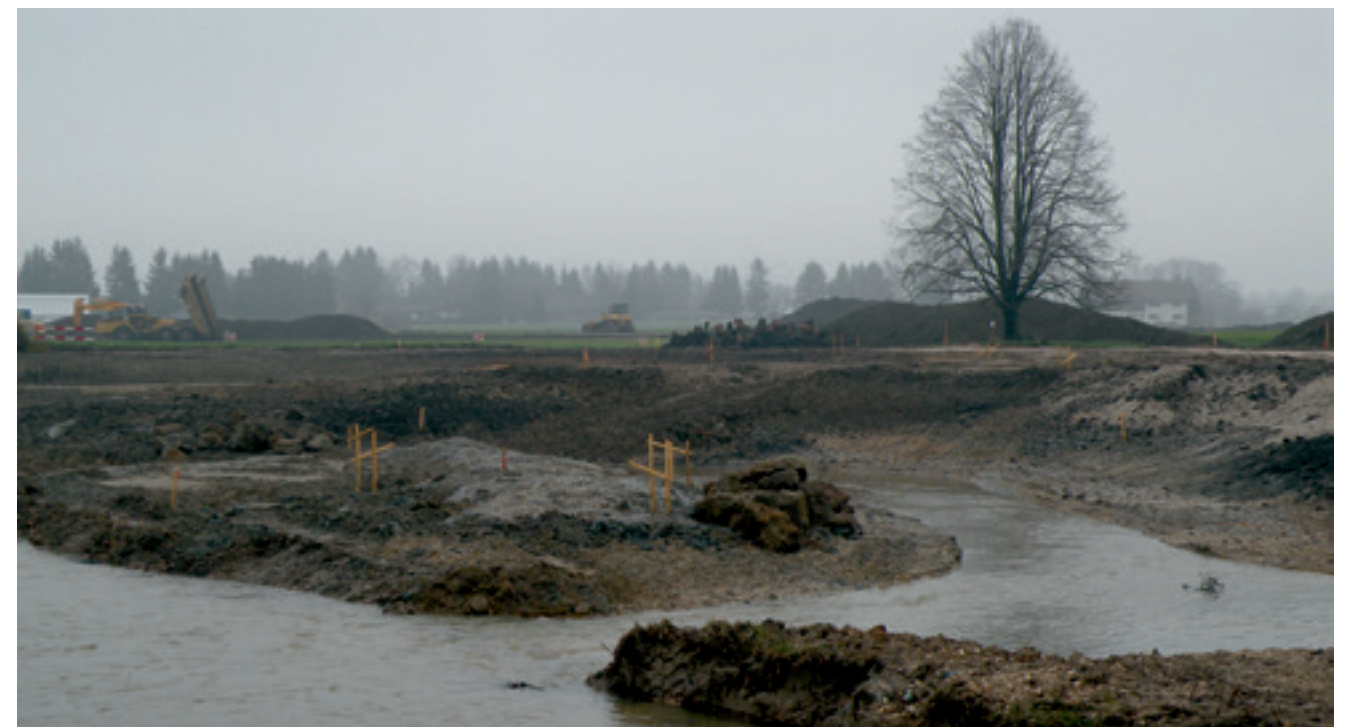
Die neuen Mäander wurden an das Bachbett angeschlossen und werden seither durchströmt.
