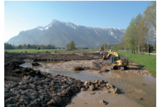
Die Schotterinseln wurden durch große Konglomeratblöcke gesichert.
