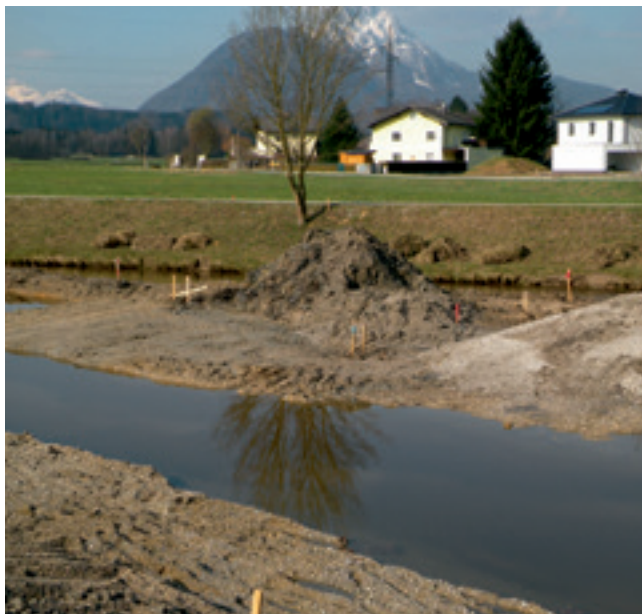
Ein neues Gewässerbett wurde ausgehoben und Schotterinseln wurden aufgeschüttet.
