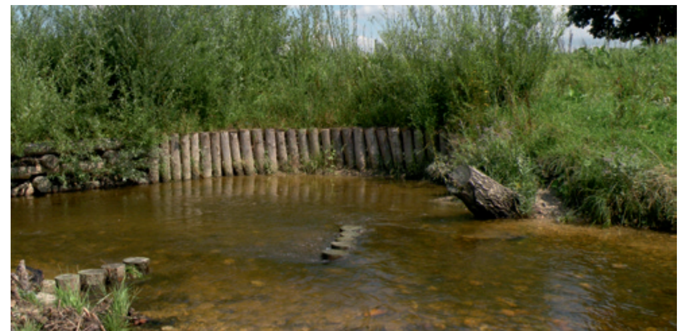
Buhnen aus Holzpiloten sorgen für mehr Diversität in der Strömung.
