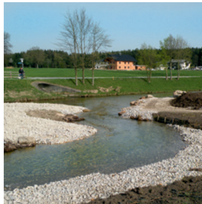
Durch die neu geschaffenen Flussschlingen wurde die Fließstrecke der Glan verlängert.
