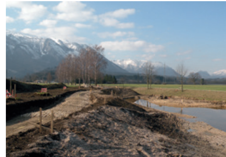
Zunächst musste der Treppelweg mit der darin verlaufenden Gasleitung neu verlegt werden.
