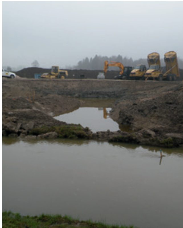
Der Voraushub der Mäander blieb vorerst vom Bachbett der Glan getrennt.
