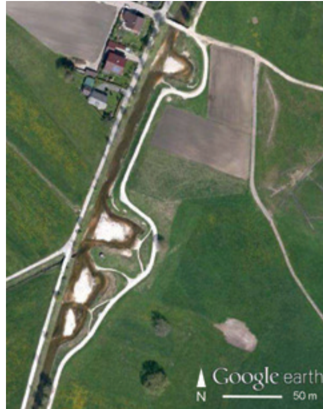
Luftbild des 2011 gebauten Restrukturierungsabschnittes der Glan.
