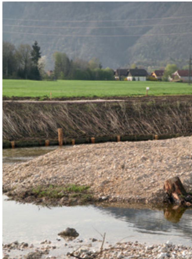
Wurzelstöcke und Störsteine strukturieren das Bachbett.
