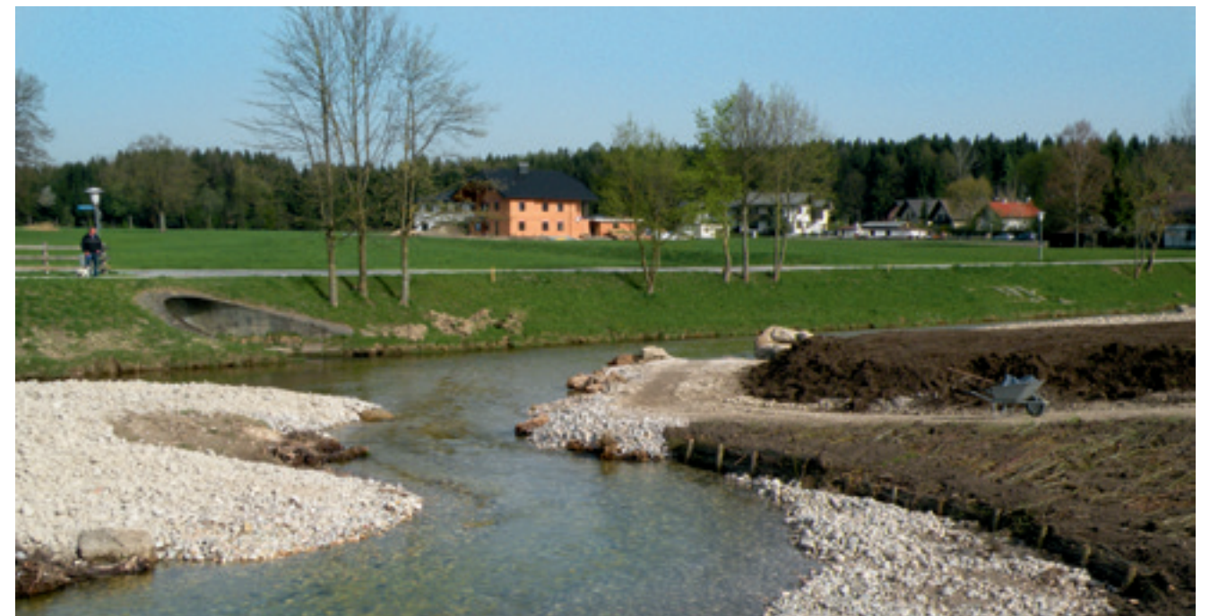
Faschinen und Weidenspreitlagen wurden als ingenieurblogische Maßnahmen am Ufer angebracht.
