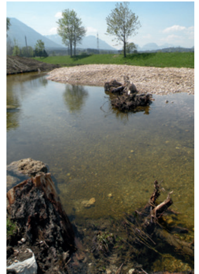
Im Bachbett wurden strömungsberuhigte Bereiche geschaffen. Die eingebrachten Wurzelstöcke dienen als Unterstand für die Fischfauna.
