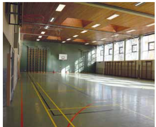
NMS-Liefering Fenstersanierung Turnsaalgebäude vom Turnsaal aus gesehen
