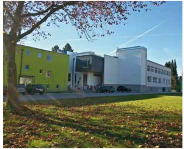
Kindergarten + Hort Liefering + neue Turnhalle NMS Liefering
