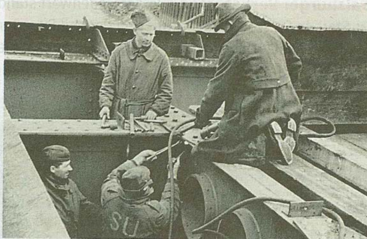
Sowjetische Kriegsgefangene beim Bau der Staatsbrücke.
