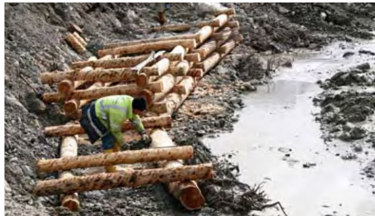
Krainerwände – eine Kombination aus Holzpflocken, Weidenstecklingen und Erde – dienen zur natürlichen Uferbefestigung.
