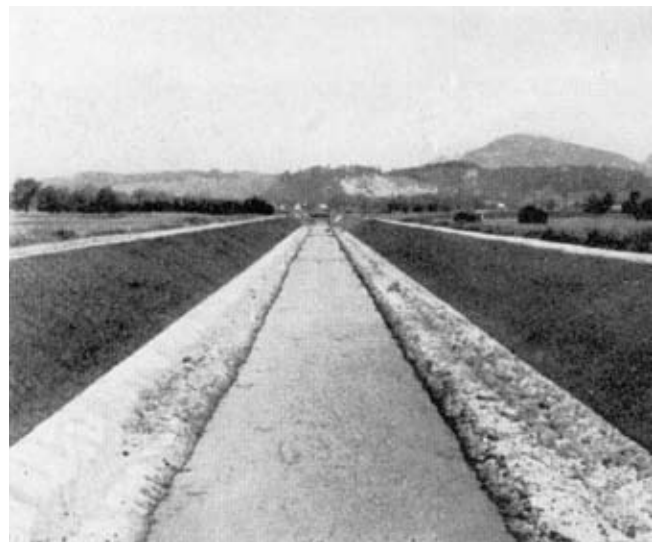
Durch die Regulierung wurde der Verlauf der Glan gestreckt und das Gewässer in ein strenges Trapezprofil gezwängt.
