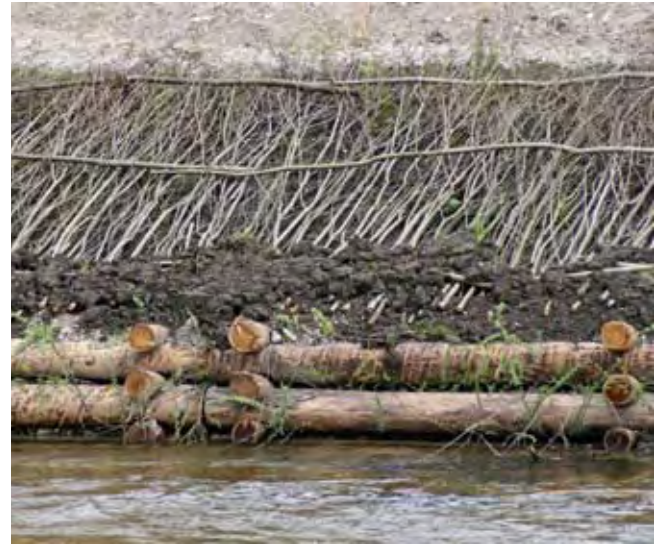
Zur naturnahen Ufersicherung werden Weidenflechtwerk...
