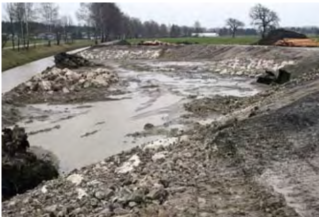
Der untere Aufweitungsbereich ist größtenteils ausgehoben, das Gewässer fließt vorerst noch in seinem alten Bett.
