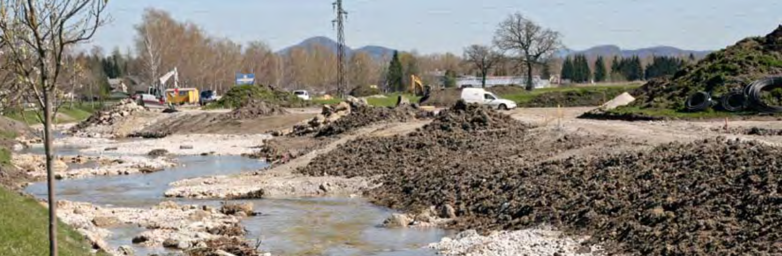
Der leicht mäandrierende Verlauf bringt die Bildung von Schotterflächen und Tiefenbereichen mit sich.
