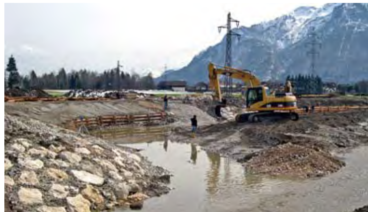
Im unteren Aufweitungsbereich wird Material aufgeschüttet und damit die zentralen Inseln vorbereitet.
