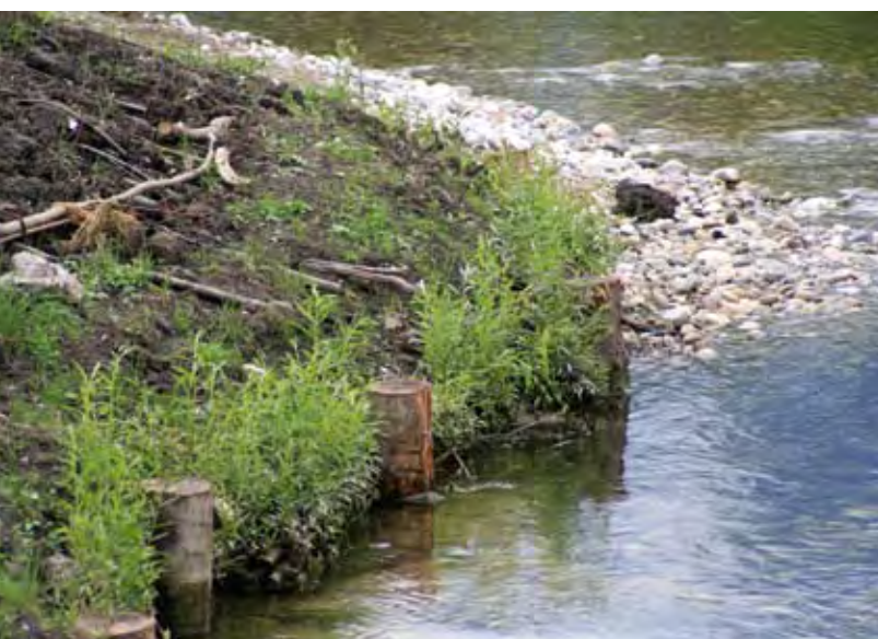
Das Weidengeflecht am Ufer wächst gut an und bietet so die gewünschte Stabilität.
