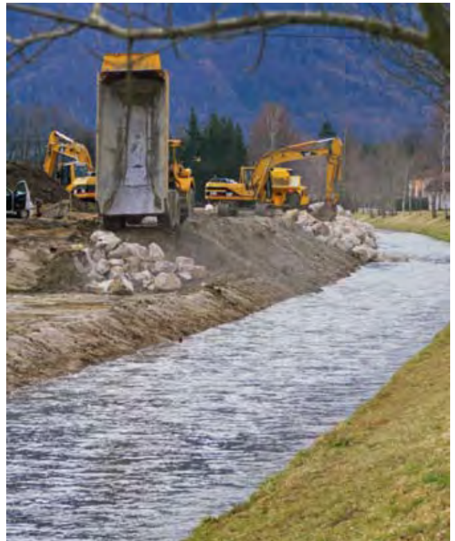
Um Seitenerosion zu verhindern, werden an gefährdeten Stellen Steinsicherungen eingebaut.
