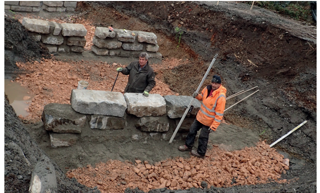
Abbildung 4.19: Die Errichtung der einzelnen Riegel der Fischaufstiegshilfe. Im Bild Arbeiter der Firma Stöckl.
