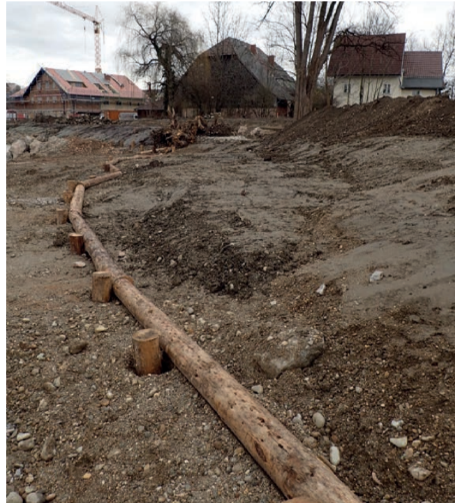
Abbildung 4.16: Rechtsufrig wurde im aufgeweiteten Bereich eine Fußsicherung platziert.
