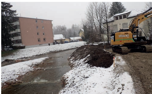
Abbildung 4.27: Der Instandhaltungsweg verläuft bis zum fünften Becken. Ein Bagger trägt die letzte Schicht Humus auf.
