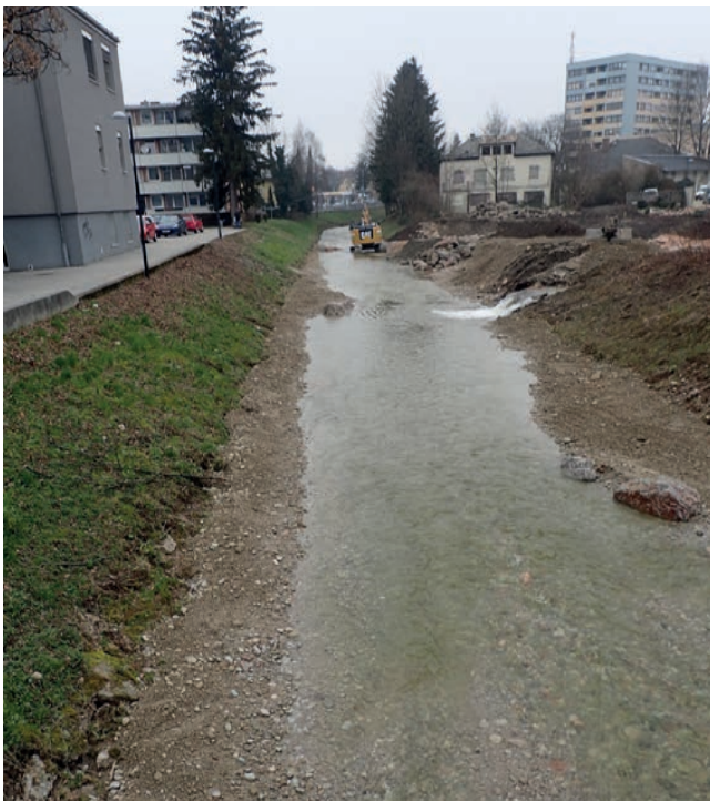
Abbildung 4.24: Im unteren Projektbereich werden die letzten Arbeiten in der Glan ausgeführt.
