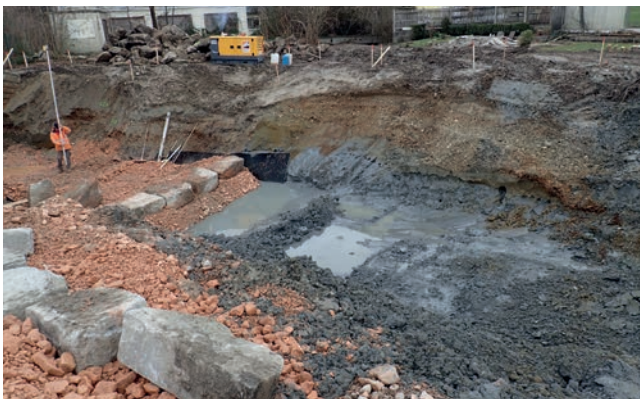
Abbildung 4.15: Die Anfänge der Fischaufstiegshilfe im Mühlbach.
