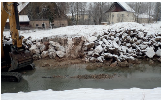
Abbildung 4.5: Entfernung der Sohlpflasterung und der Uferbefestigungen auf der rechten Glanseite.
