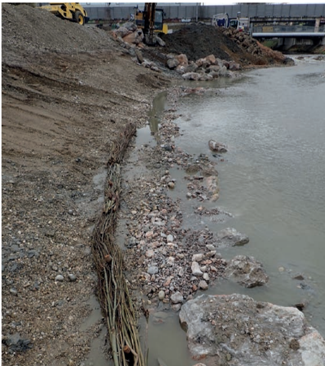
Abbildung 4.18: Weidenfaschinen stabilisieren die Übergangszone von Wasserkörper zu Ufer.
