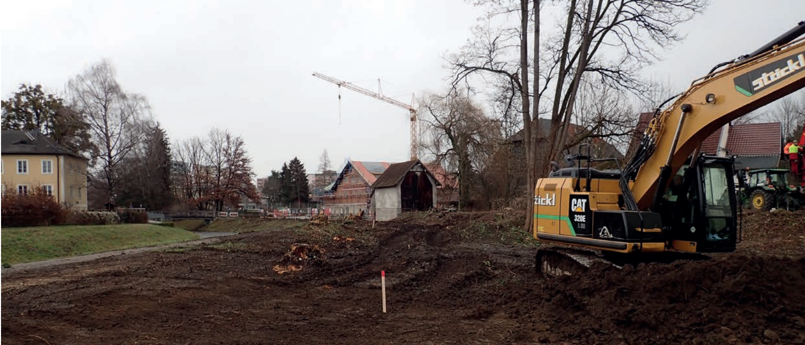
Abbildung 4.2: Im Bild sichtbar sind die alte Remise und die erhaltungswürdige Robinie.
