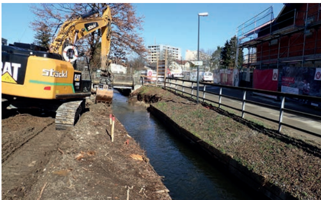
Abbildung 4.21: Ersichtlich ist hier die Entfernung der Beschlächtung des Mühlbaches.
