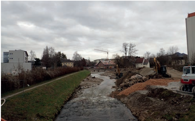
Abbildung 4.14: Überblick über den oberen Projektabschnitt in der fünften Woche. Zu sehen sind die Schotterinseln (Buhnen).
