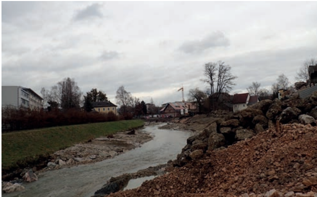
Abbildung 4.17: Übersicht über den oberen Projektbereich während der fünften Woche.
