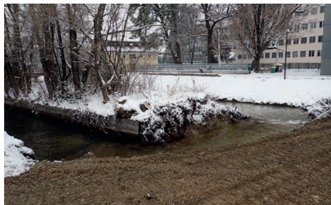
Abbildung 4.6: Der Mühlbach fließt provisorisch beim Überlaufschutz ab.
