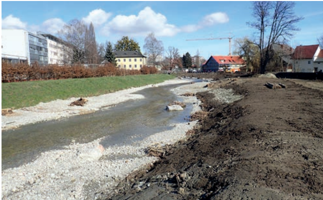
Abbildung 4.23: Übersicht über das fertige Gewässerbett der Glan im oberen Projektbereich während der achten Woche.
