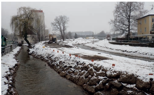
Abbildung 4.26: Vorbereitung des Unterbaus für den Geh- und Radweg auf der rechten Glanseite.
