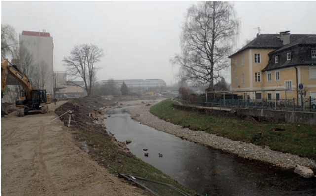
Abbildung 4.28: Arbeiten am Frostkoffer im oberen Projektbereich in der zehnten Woche.
