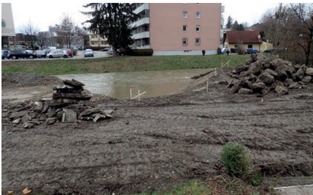
Abbildung 4.12: Das erste Becken der Fischaufstiegshilfe des Mühlbaches ist ebenso überschwemmt.
