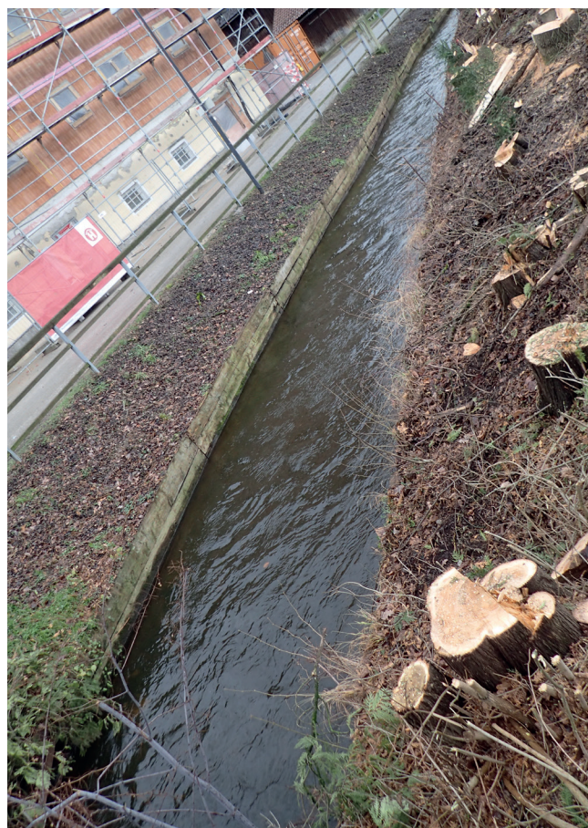
Abbildung 4.3: Der Mühlbach vor seiner Restrukturierung – ein monotoner Bach.
