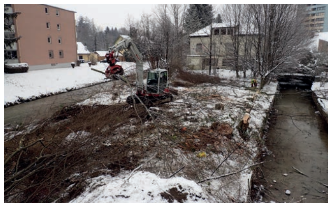
Abbildung 4.7: Die Schlägerungsarbeiten im Bereich des Mühlbaches. Auf der rechten Seite ist der alte Kanal des Mühlbaches zu erkennen, der bereits von der neuen Wasserzufuhr abgeschnitten ist.
