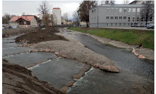
Abbildung 4.30: Die fertige Fischaufstiegshilfe am 24. März mit Blick Richtung Annahofsteg.
