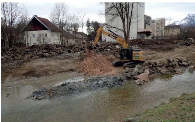
Abbildung 4.9: Gestaltung des Stillwasserbereiches mit dem markanten roten Weißenbacher Kalk.
