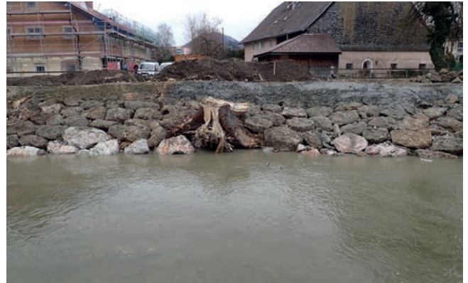
Abbildung 4.10: Eingebauter Wurzelstock, der nun als Fischunterstand dient.
