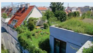
Intensivbegrünung, Ort: Wien © GRÜNSTATTGRAU
