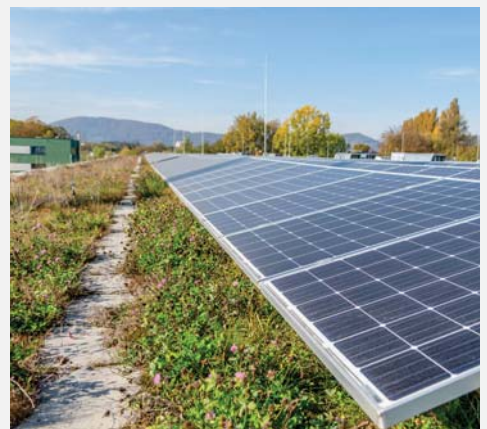
Die fachgerechte und interdisziplinäre Planung und Ausführung ist bei der Solargründächern vorauszusetzen. Ort: Graz © achtzigzweiJane
