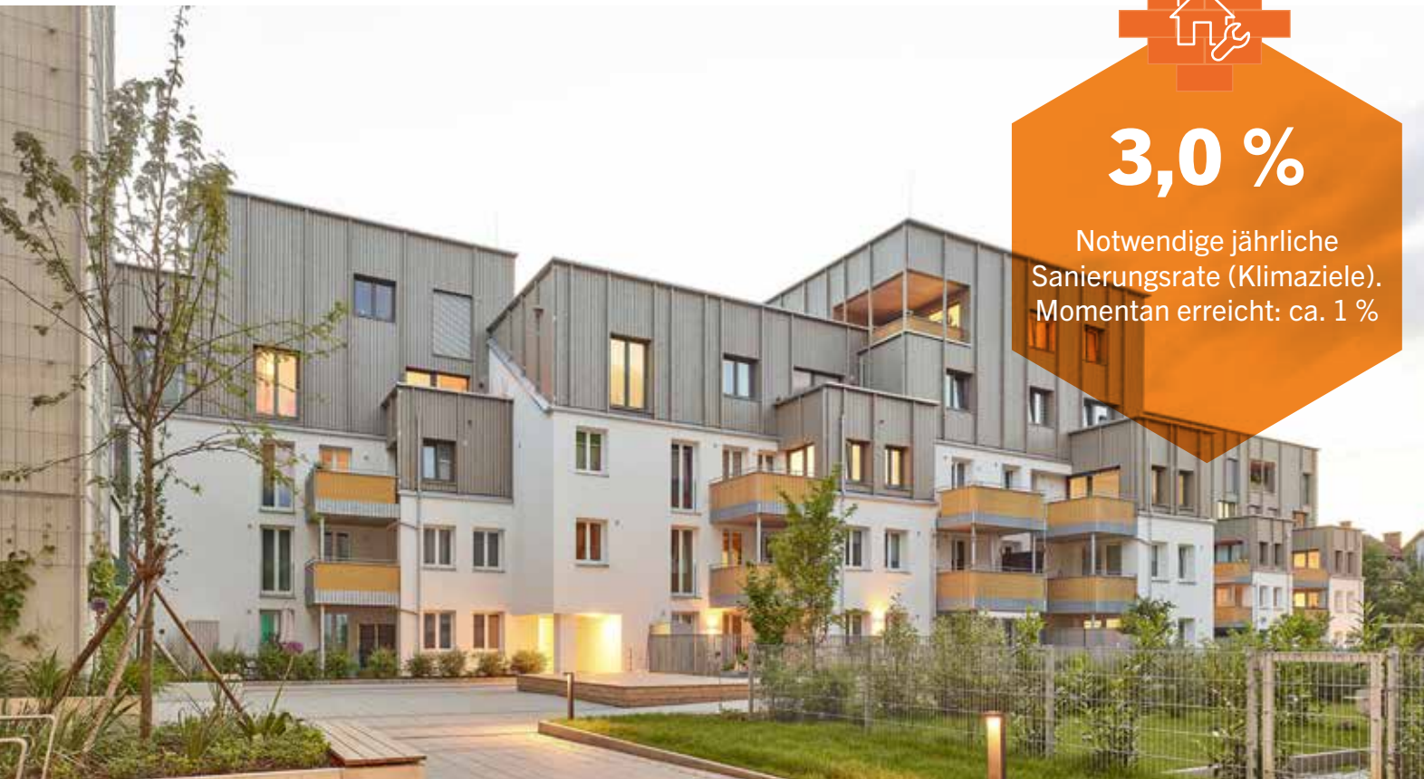
Bestandsentwicklung „Wir Inhauser“, Fertigstellung 2024
